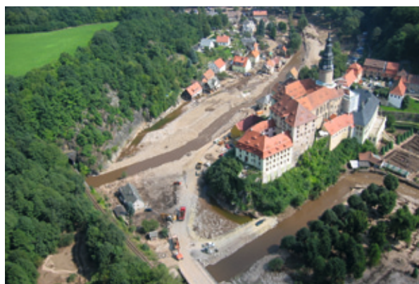
Hochwasserschäden 2002 in Weesenstein an der Müglitz ...
