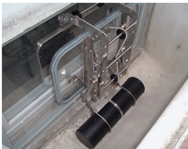
Automatisch schließende Vorsatzscheibe
