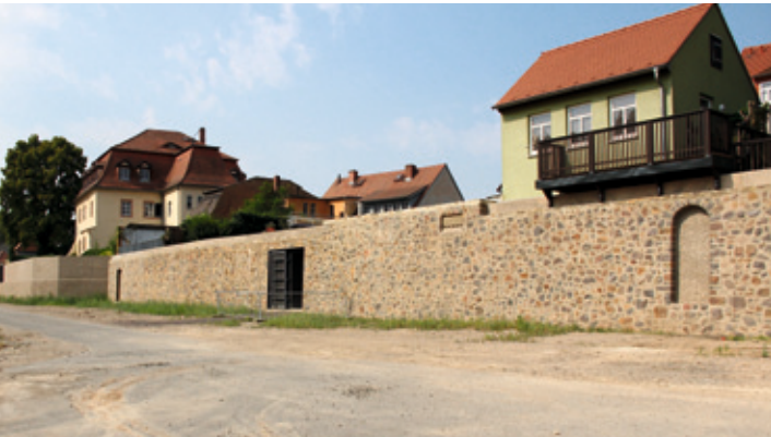
Integrierter Hochwasserschutz in der historischen Stadtmauer ...
