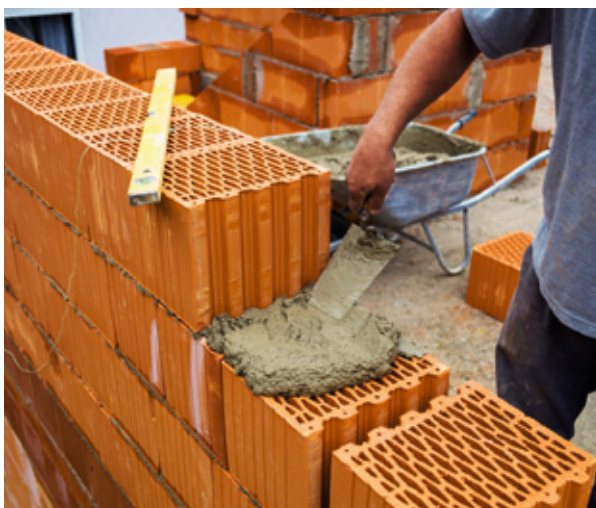
Mauerwerk aus Hochlochziegel
