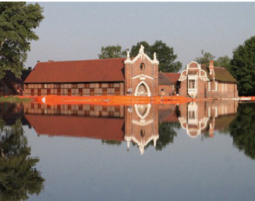
Objektschutz mit mobilem wassergefülltem Schlauchsystem
