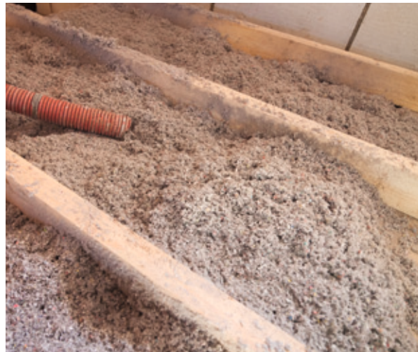
Anwendung von Zelluloseflocken im Fußbodenbereich
