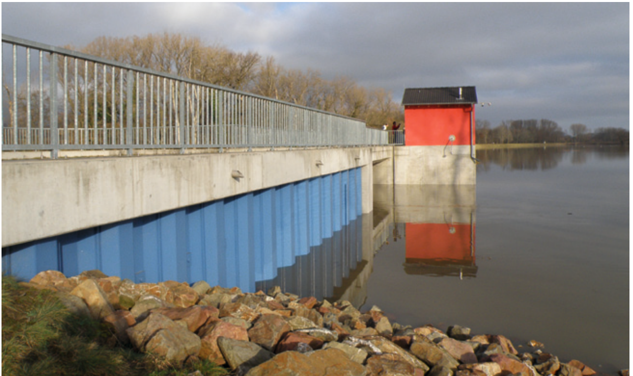
Polderflutung am Rhein bei Ingelheim
