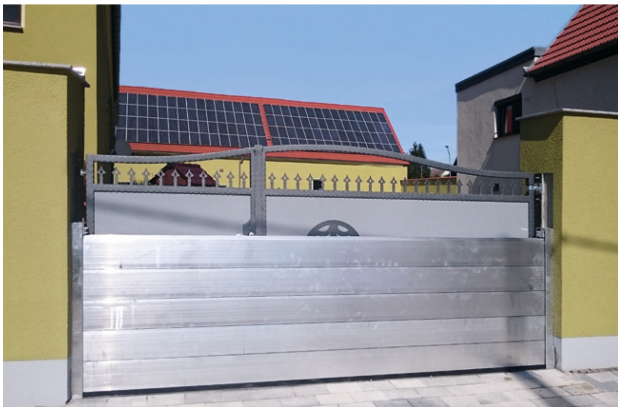
mobiler Hochwasserschutz mit Dammbalken
