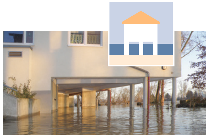
Ausweichen: zum Beispiel durch Aufständern von Gebäuden
