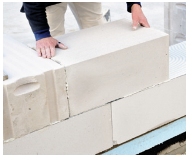
Mauerwerk aus Porenbeton-Plansteinen
