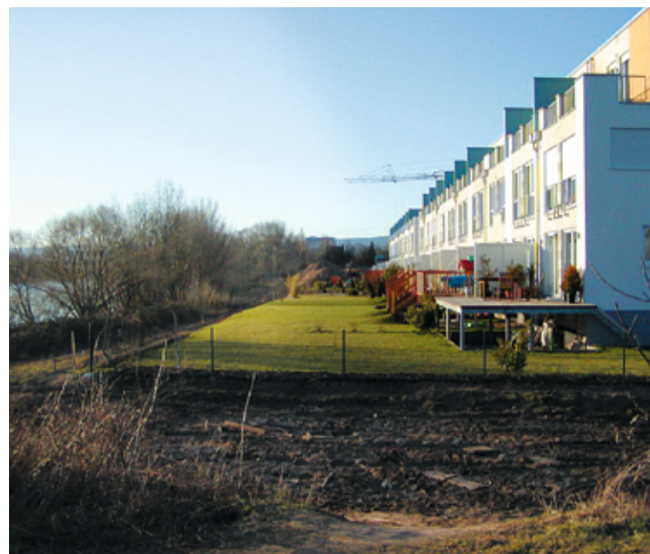
Hochwasserangepasste Bauweise mit erhöhtem Erdgeschoss
