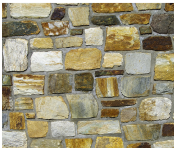
Unregelmäßiges Natursteinmauerwerk
