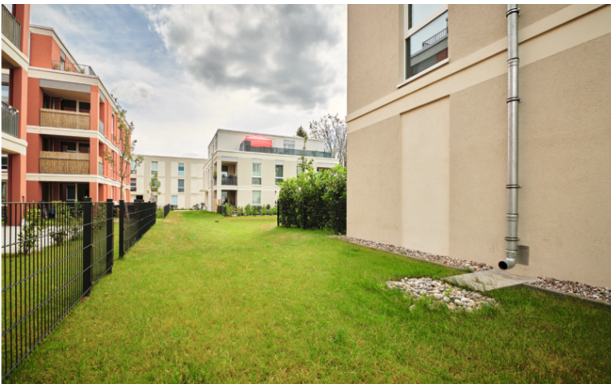
Dezentrale Rückhaltung von Niederschlagswasser
