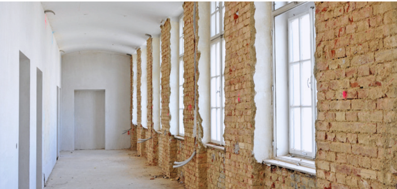
Entfernter Putz zur besseren Trocknung einer Außenwand
