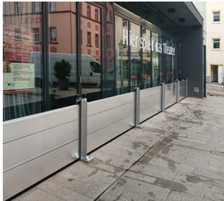
Objektschutz mit teilmobilen Schutzelementen
