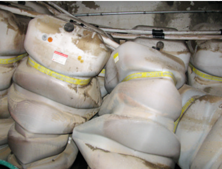
Zerstörte Heizöltanks infolge einer Hochwassereinwirkung
