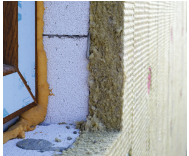
Einsatz von Mineralfaserplatten als Außenwanddämmung
