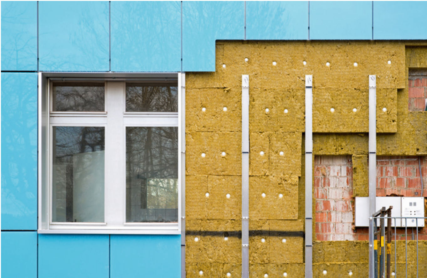
Hinterlüftete Fassadenkonstruktion
