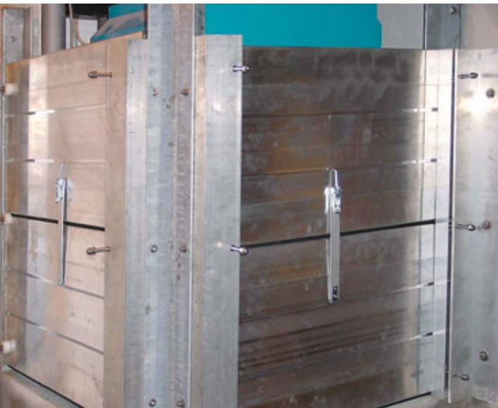
Sicherung einer Feuerstätte vor dem Wasserzutritt
