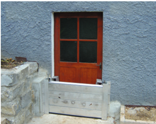
Objektschutz an Gebäudeöffnungen
