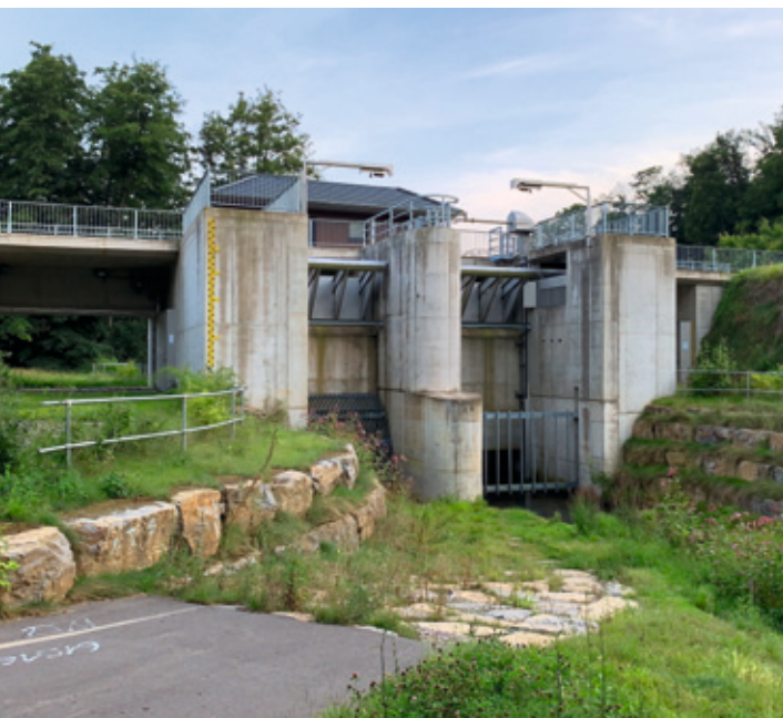
Verschlussbauwerk eines Hochwasserrückhaltebeckens
