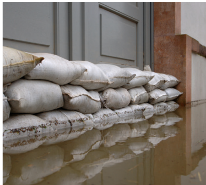
Notfallmäßiger Objektschutz mit Sandsäcken
