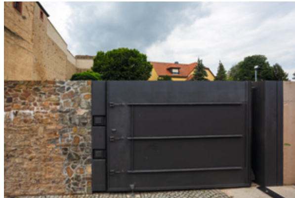
... und Fluttor in Grimma an der Mulde
