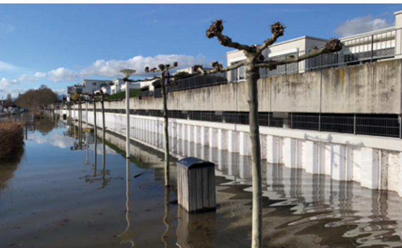
Hochwasserschutzwand mit eingerammter Stahlpundwand
