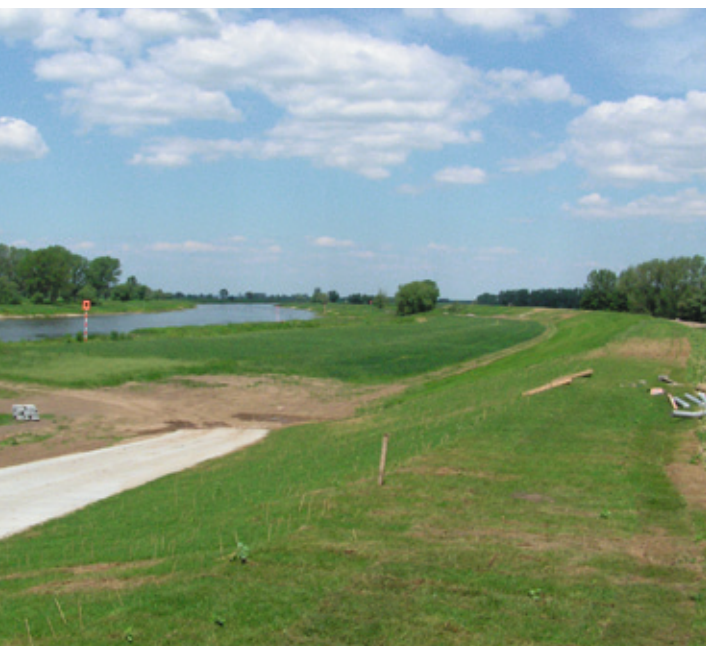
Saniertes Hochwasserschutzdeich an der Elbe
