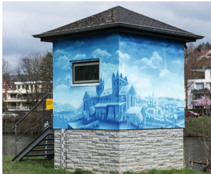
Pegelhaus an der Ruhr
